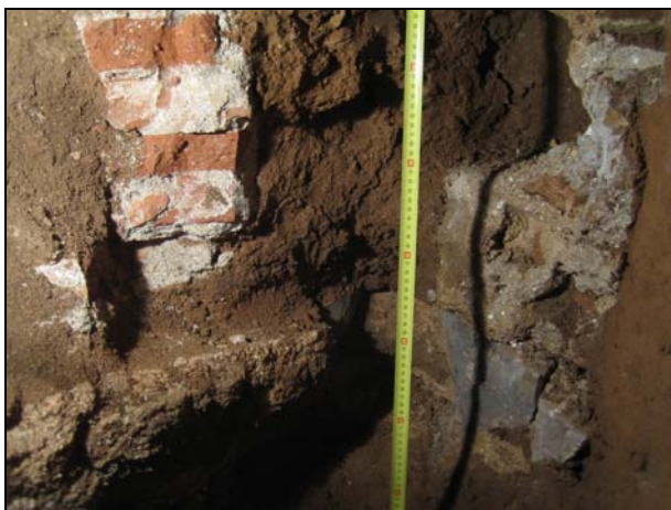
FOTO 7. En aquesta imatge podem comparar els morters de la canalització UE 106 (a la dreta) i UE 111 (a l'esquerra), que amortitza la primera
