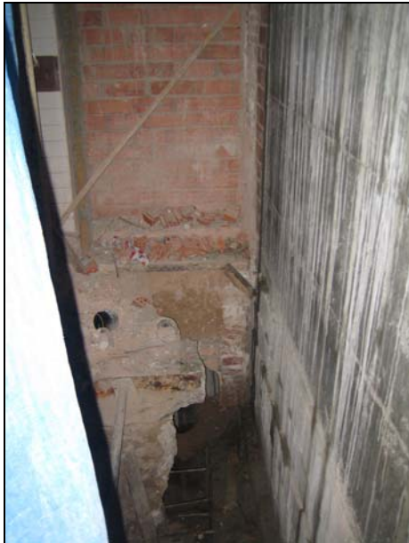
FOTO 5. Mur pantalla que es va construir al NO de la cala
